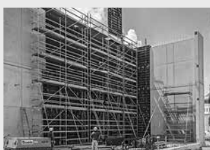
Pracovné lešenie na stavbách
