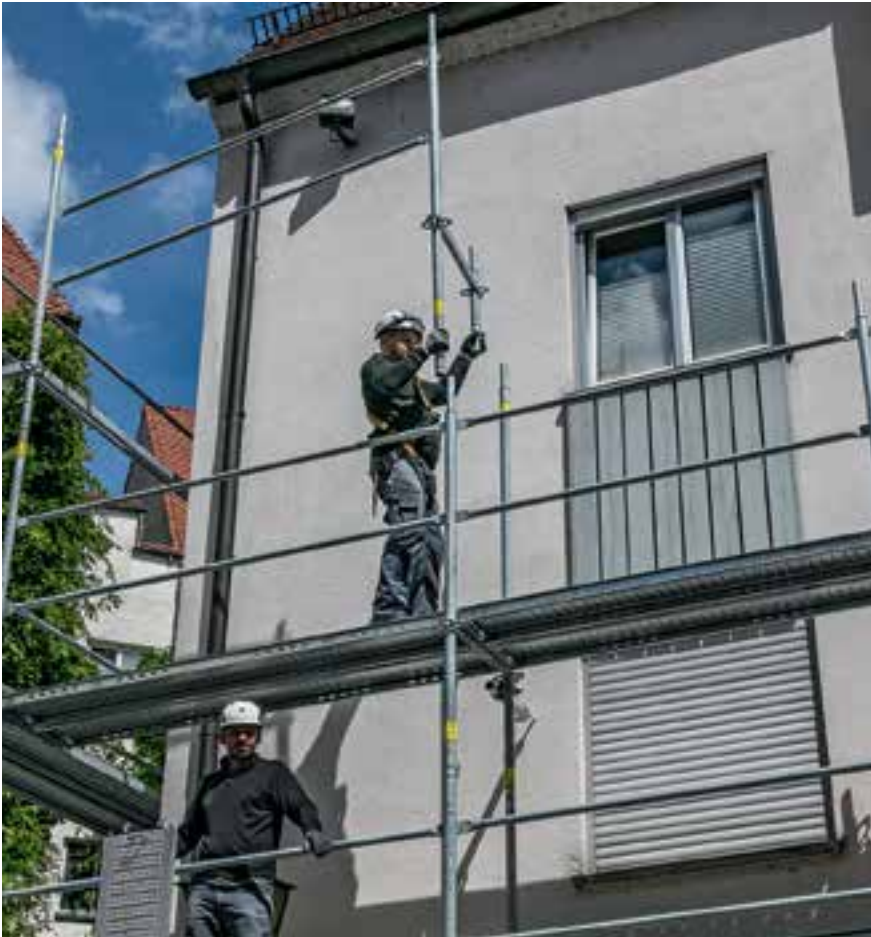
Ako variant môžu byť obe zábradlia uchytené o rám Easy a montované zo spodnej úrovne.
