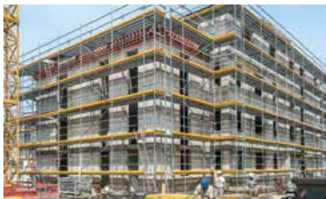
Obytný súbor Killisfeldstraße, Karlsruhe, Nemecko
