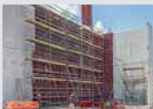
Pracovné lešenie na stavbách
