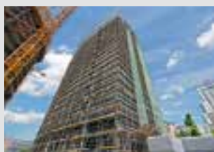
Pracovné lešenie fasády
