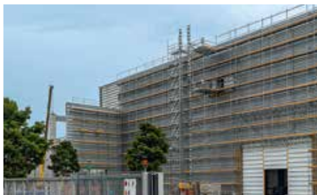
Rozšírenie továrne pre technológiu polovodičových zariadení firmy Zeiss, Oberkochen, Nemecko
