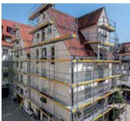
Sanácia bytového domu, Ulm, Nemecko
