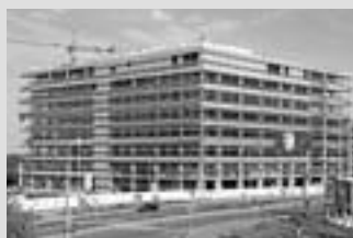
Pracovné lešenie fasádne
