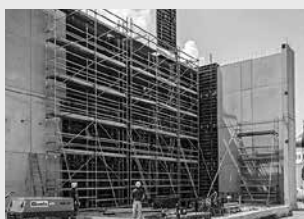
Pracovné lešenie na stavbách
