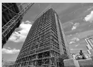
Pracovné lešenie fasáde
