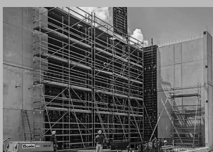
Pracovné lešenie na stavbách
