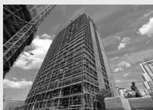
Pracovné lešenie fasádne
