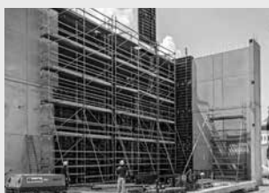
Pracovné lešenie na stavbách
