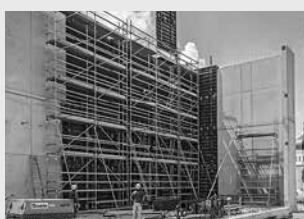
Pracovné lešenie na stavbách
