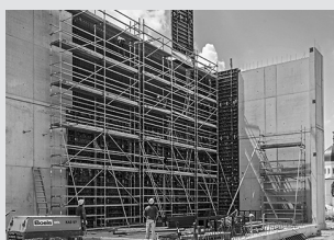
Pracovné lešenie na stavbách
