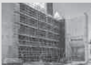
Pracovné lešenie na stavbách
