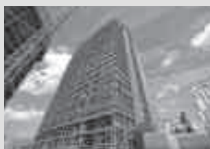
Pracovné lešenie fasádne
