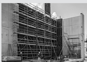
Pracovné lešenie na stavbách
