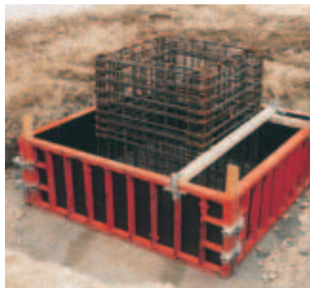
panely naležato pre debnenie základov
