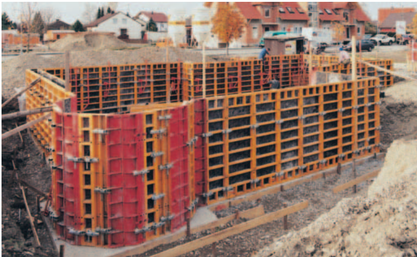
TRIO-L má k dispozícii vždy 4 šírky panelov k výške 270 cm a 90 cm.
