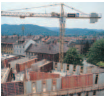
Debniace jednotky 9 m široké a 2,70 m vysoké obložené hladkou betonárskou doskou veľkého formátu.
