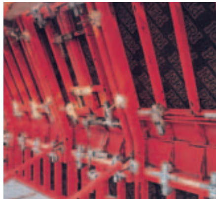
TRIO na šikmej strešnej atike Zlom bol vytvorený klbovým rohom a atypickou závorou. Vertikálne zataženie bolo prenesené do stropnej konštrukcie pomocou závor a stabilizátorov.
