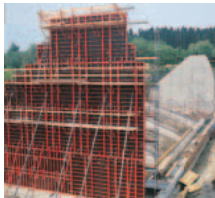
13,20 m vysoká stena
