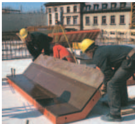
Rohové panely 135° obložené veľkoformátovou doskou na stavbe hotelu.
