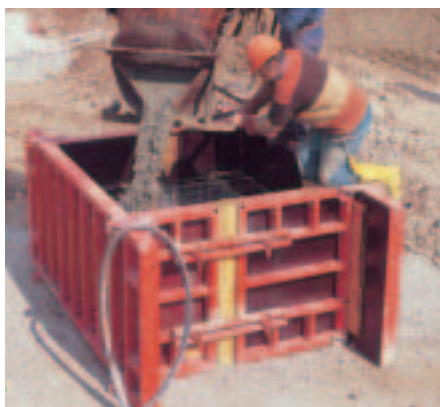
TRIO základová príložka pri nezávislom presahovaní panelov.
