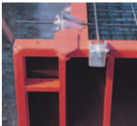
TRIO základová príložka v spolupôsobení s kotevným držiakom.
