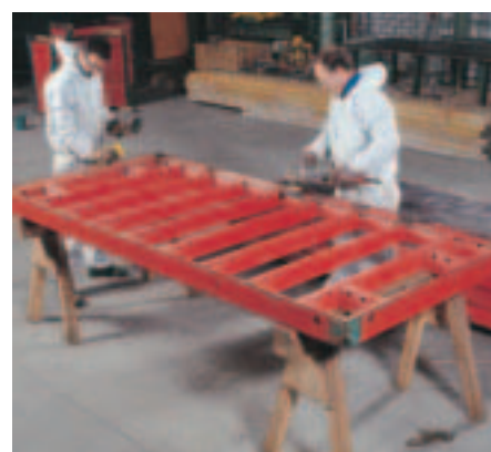
Robíme údržbu a opravy debnenia.
