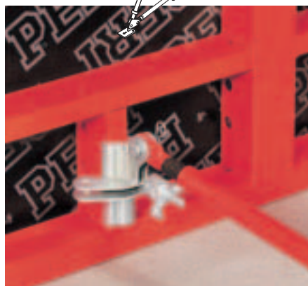
Stabilizátory a výložníky je možné pripevniť vertikálne aj horizontálne.
