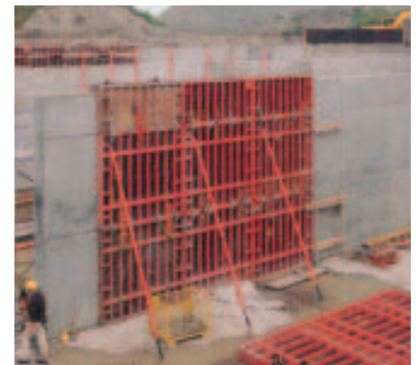
panely naležato nadstavené do výšky 6,0 m
