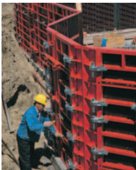
na klbovom rohu
