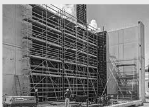
Pracovné lešenie na stavbách
