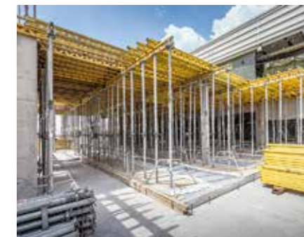
Pre debnenie stropu bol použitý rýchly a spoľahlivý debniaci systém PERI MULTIFLEX.
