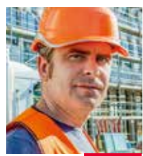
Zhotoviteľ fasády Ingsteel s.r.o., Bratislava Návrh lešenia PERI Senec
