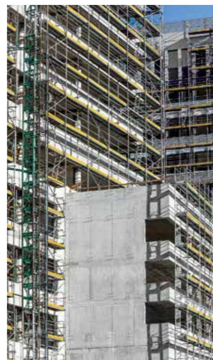
Kotvenie lešenia bolo realizované rozopretím do stropov.
