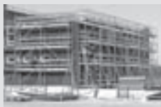
Pracovné lešenie na stavbách
