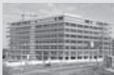
Pracovné lešenie fasádne
