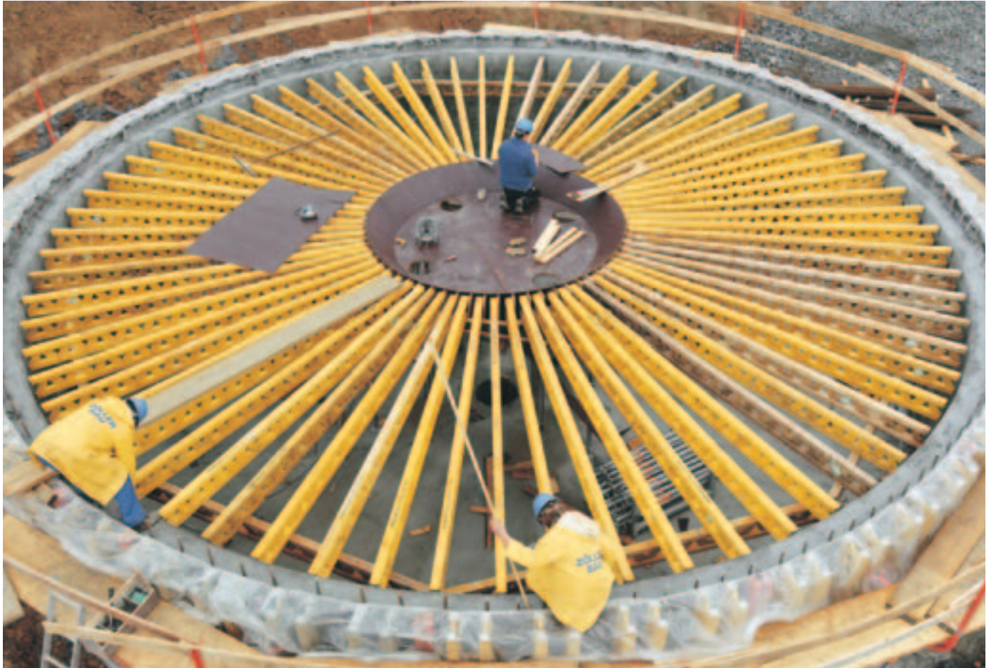
MULTIFLEX s nosníkmi GT 24 na kruhovom zásobníku o priemere 11,60 m s kuželovitou doskou.
