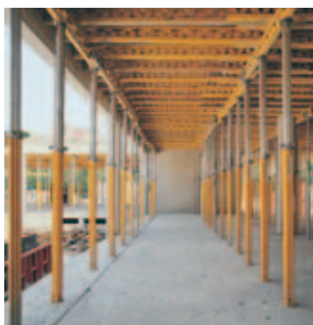
MULTIPROP MP 350 s nosníkmi GT 24 ako dolný a horný nosník pri stropnom debnení MULTIFLEX.
