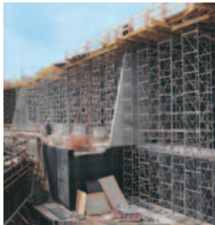
Pri veľkých výškach stropov sú podperné veže ST 100 ideálnymi podporami pre MULTIFLEX vzhľadom k ľahkej montáži a vysokej bezpečnosti.
