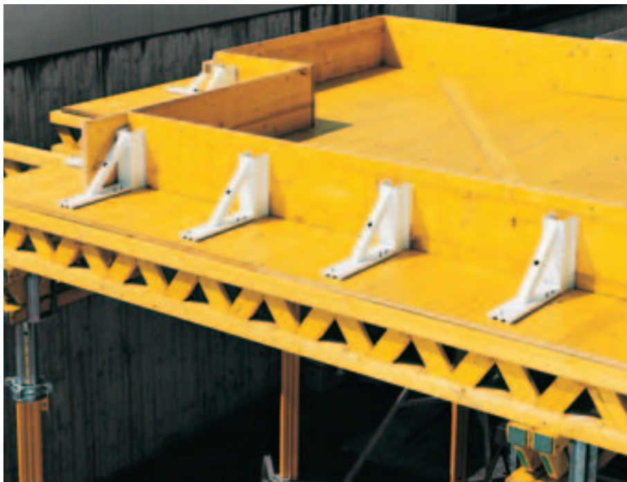
Základný rám AW slúži k odebneniu čiel stropných dosiek do výšky 40 cm.
