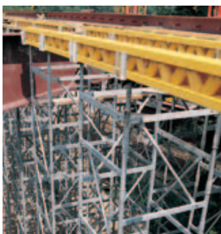
Křížová hlava ST 100 zaistí bezpečne dva nosníky GT 24 proti sklopeniu.
