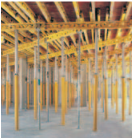
Zmenou smeru dolných nosníkov a presahmi horných nosníkov sa dá MULTIFLEX nasadiť na každý pôdorys.
