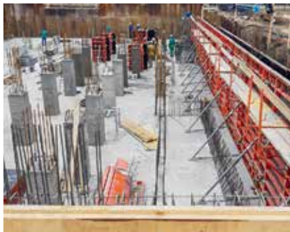
Bazény oblúkových tvarov boli podopreté stĺpovým systémom, ktorý bol postavený pomocou systému QUATTRO, a steny systémom TRIO.
