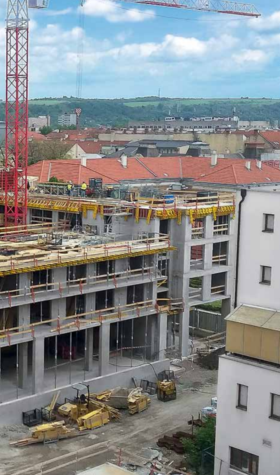
Projekt s nadčasovou architektúrou, s veľkou pôdorysnou rozlohou a rozmanitosťou si vyžiadal, aby pre maximálne využitie debnenia dodaného na stavbu navrhlo technické oddelenie PERI výkres pre každé podlažie budovy zvlášť.
