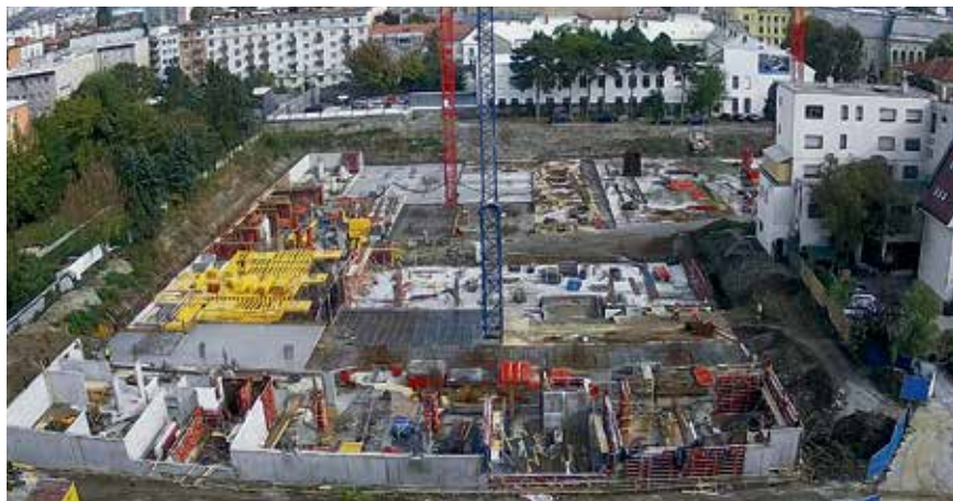
Projekt s nadčasovou architektúrou, s veľkou pôdorysnou rozlohou a rozmanitosťou si vyžiadal, aby pre maximálne využitie debnenia dodaného na stavbu navrhlo technické oddelenie PERI výkres pre každé podlažie budovy zvlášť.
