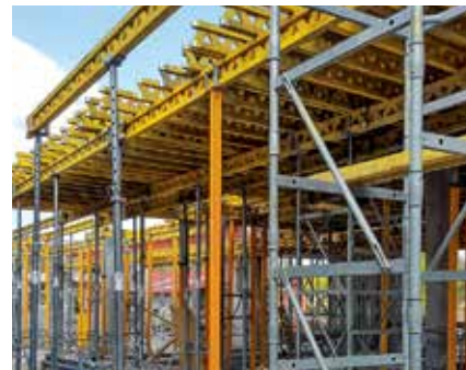
Stropy nad bazénom so svetlou výškou od 4 200 mm do 5 215 mm vyrástli pomocou nosníkov GT 24 na podpernej konštrukcii zo systémov MULTIPROP, PERI UP Flex a ST 100.
