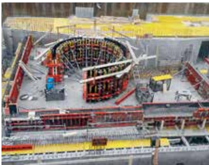
Oblúkové tvary bazénov odliate pomocou systémov debnenia MULTIFLEX, RUNDIFLEX a QUATTRO.
