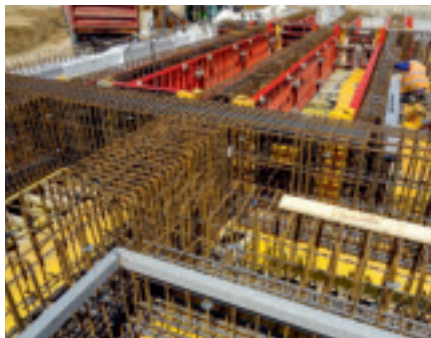
Debnenie masívnych prievlakov bolo podopreté priestorovou konštrukciou z lešenia PERI UP Rosett.
