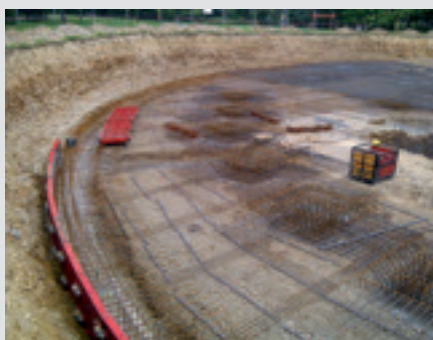
Na debnenie základne podzemného podlažia v tvare kruhu bolo použité debnenie DOMINO.
