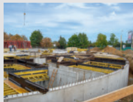
Vďaka systémovým prvkom PERI bolo možné dosahovať požadované výsledky betonáže v krátkych časových úsekoch, pričom bol dodržaný prísny časový harmonogram pre betonáž a hrubú stavbu.
