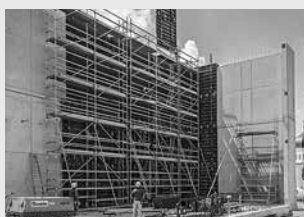
Pracovné lešenie na stavbách
