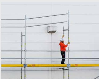
PERI UP Easy je ľahké rámové lešenie pre rýchlu realizáciu fasádneho lešenia.
