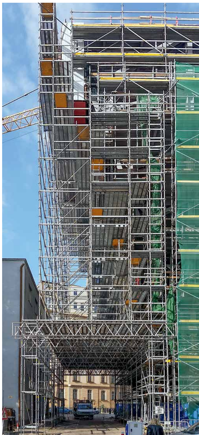
Fasáda na západnej strane budovy má tvar „obrátenej schodov“. Kotvenie lešenia k budove bolo z jednej strany riešené privarením kotiev k oceľovej konštrukcii budovy.
