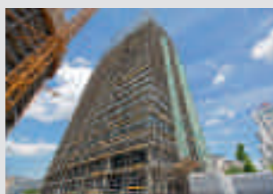
Pracovné lešenie fasádne
