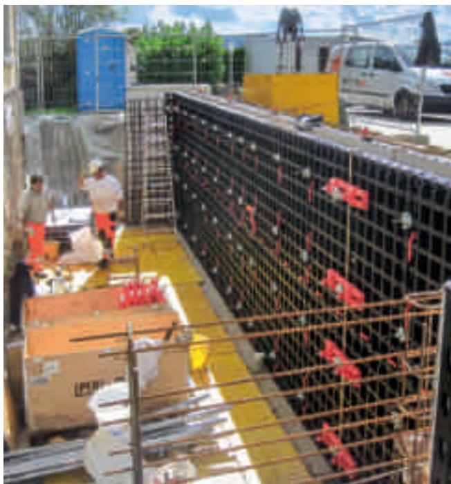
DUO bolo pre debnenie a oddebnenie bez nasadenia žeriava ideálnym riešením.
