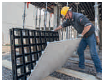
2. Odstránenie poškodenej debniacej dosky
