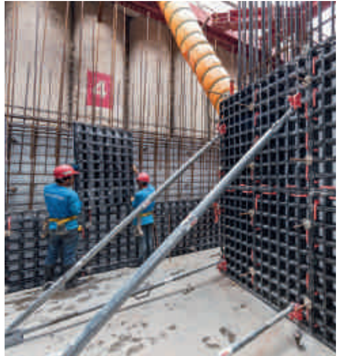
DUO naplno ukázalo svoje výhody pri debnení podzemných stien, ktorými sú nízka hmotnosť a panely s malými rozmermi.
