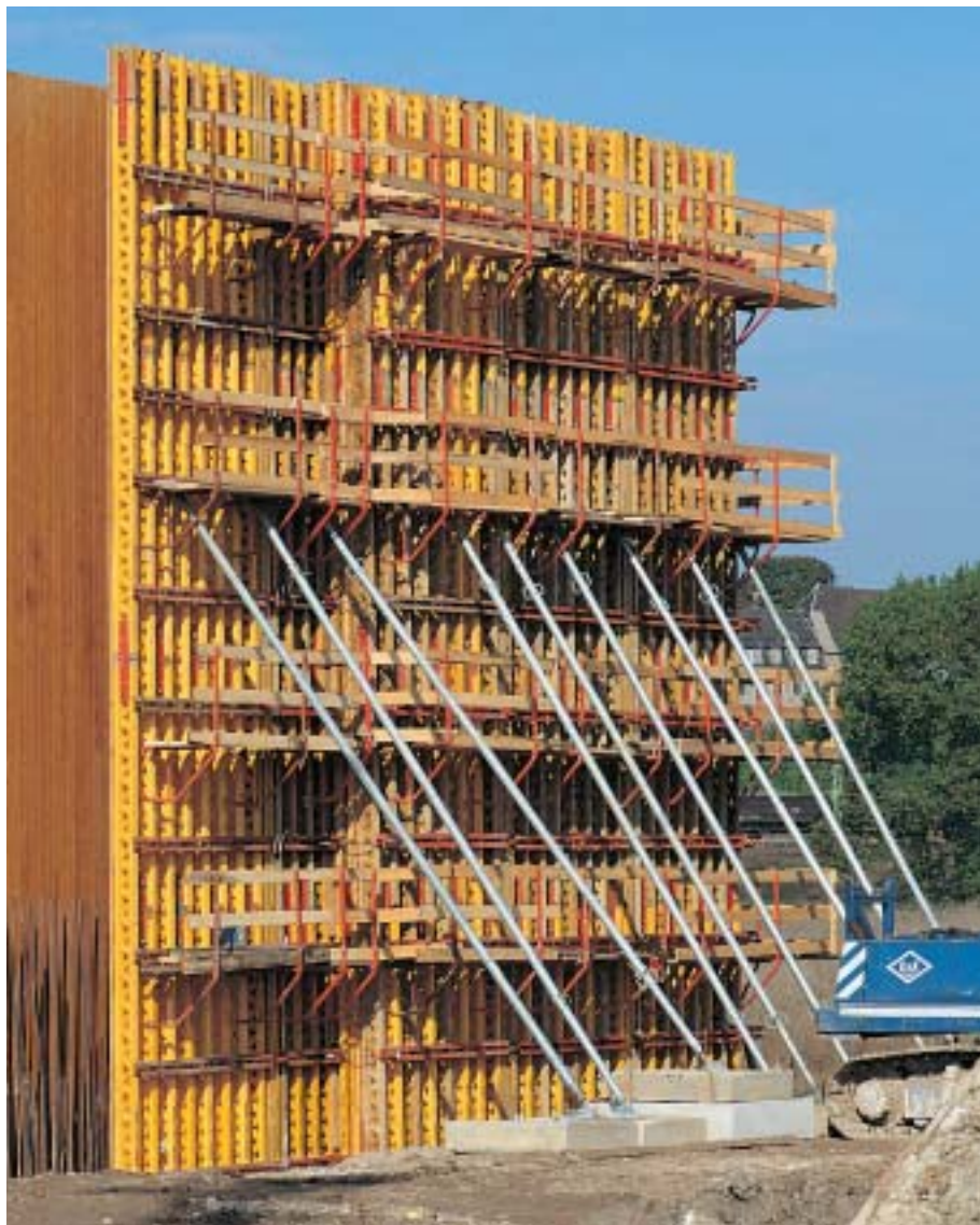
10,70 m vysoké steny s dvakrát nadstaveným postaveným debnením.
