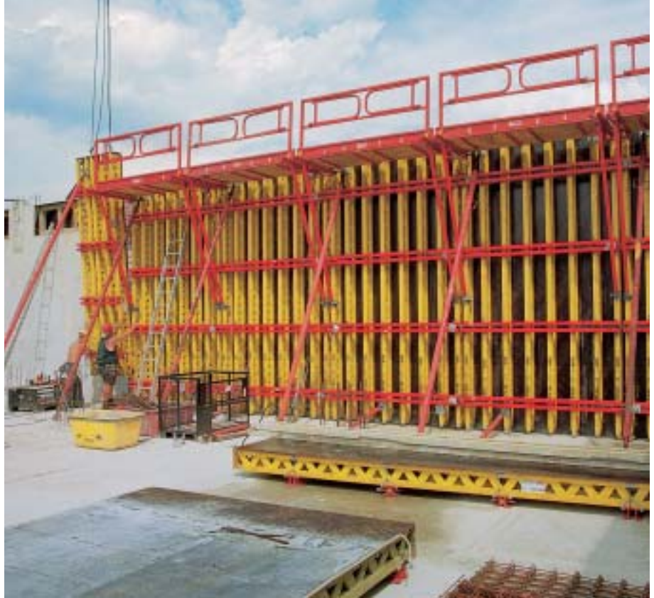
Štandardné panely VARIO GT 24 spolu s lávkami.
