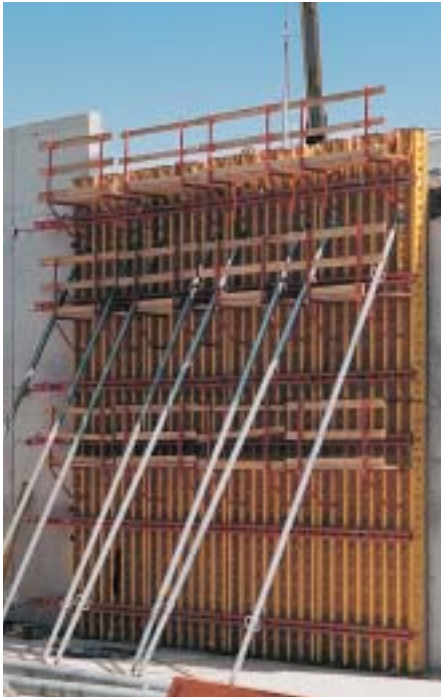
Nadstavené panely VARIO na stavbe administratívnej budovy.
