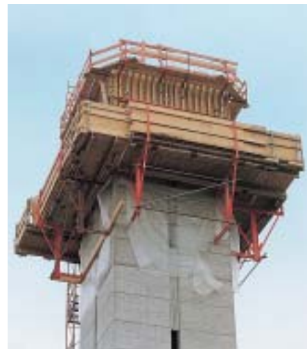
Kostolná veža vo Feldmochingu pri Mníchove (SRN). VARIO GT 24 na lešení pre prekľadané debnenie KGF 240.
