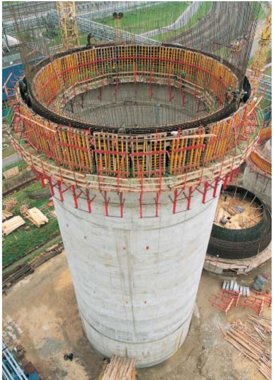
72 m vysoké silo na popolček s priemerom 20 m v elektrárni v Opole v Poľsku. Kruhové debnenie VARIO na prekľadanom lešení KGF.
