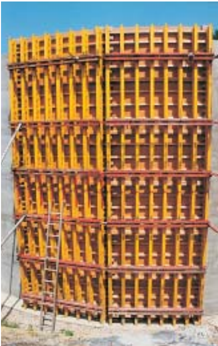
7,50 m vysoké kruhové debnenie získané vložением ramenátov medzi nosníky a preglejku.
