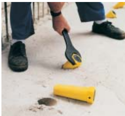
Montážne kónusy sa vyskrutkujú pomocou jednostranného kľúča 70 mm a dajú sa znova použiť.
