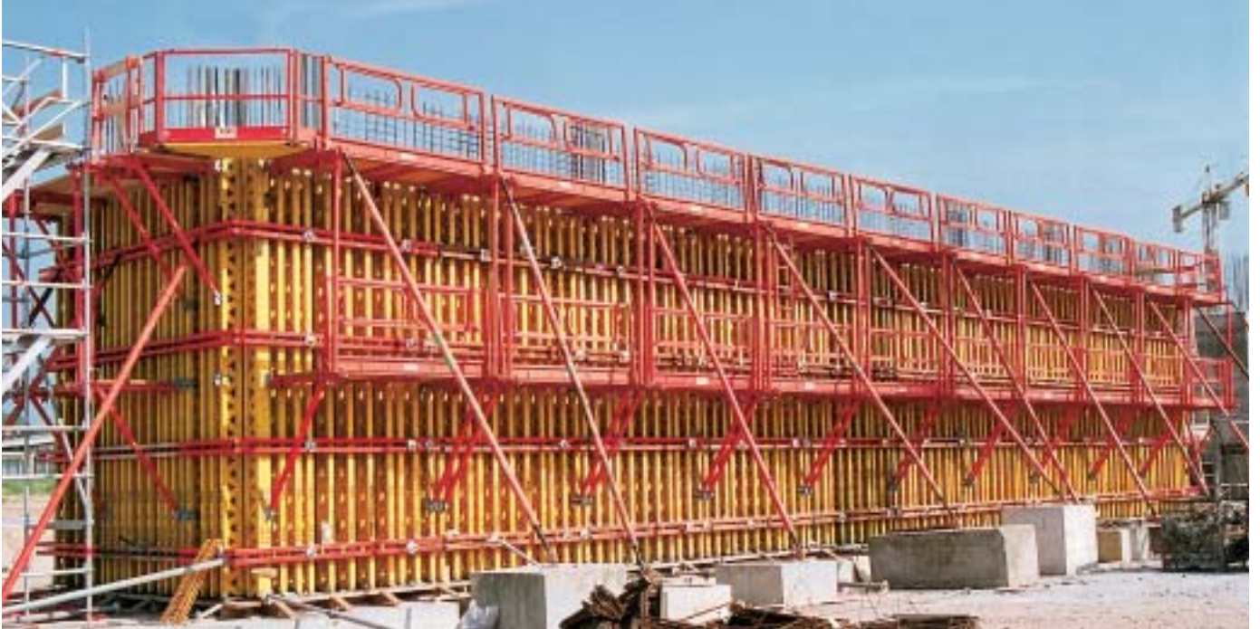
Štandardné panely VARIO GT 24 výšky 6,00 m s lávkami.
