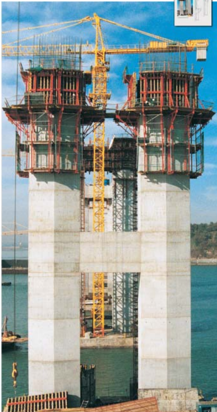
Trojuholníková konzola CB 240 umožňuje bezpečnú a efektívnu prácu pred aj za debnením.
