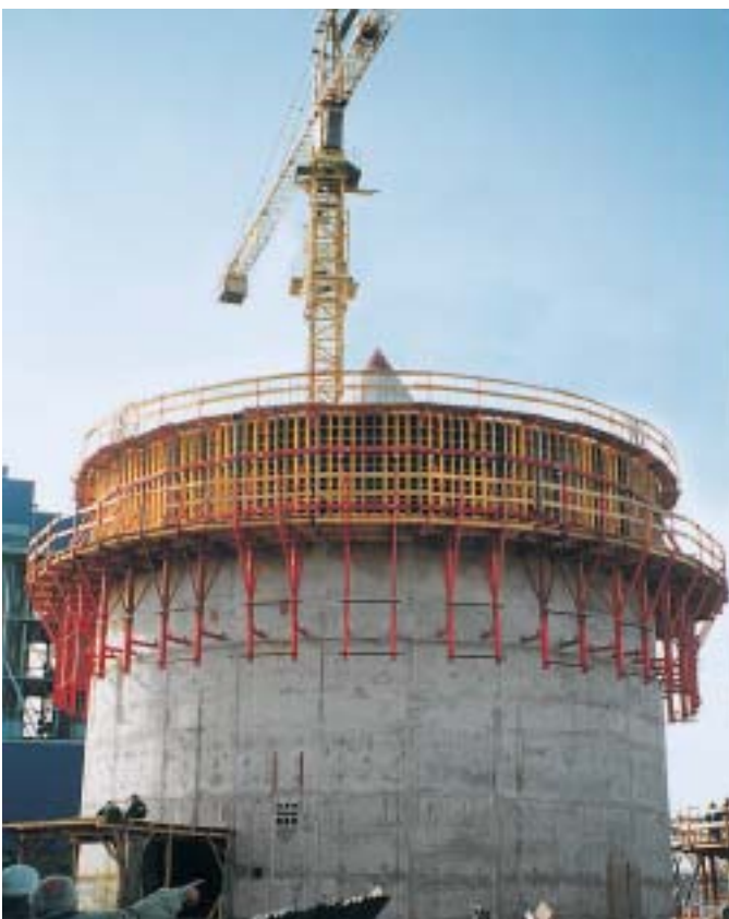
VARIO GT 24 na stavbe kruhového síla. Kruhový tvar debnenia vytvorili drevené klíny medzi nosníkmi a závorami.
