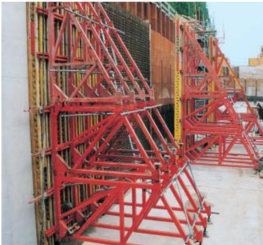
Stenové debnenie VARIO GT 24 s opornými rámami AO, A, B a C pre max. výšku betonáže 8,75 m.
