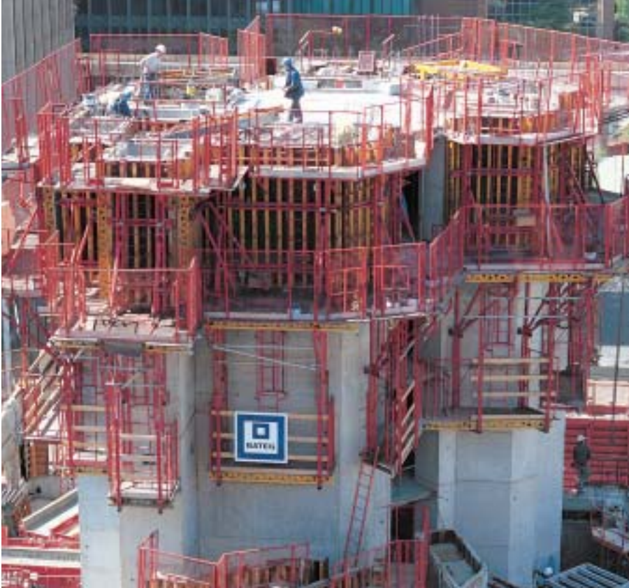
Výšková budova v Paríži s VARIO GT 24 a prekladanými konzolami CB 240.
