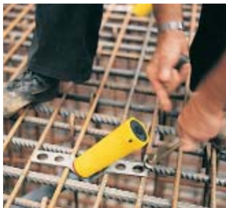
Jednoduché upevnenie kotvenia na výstuž: pomocou drôtu a klieští.
