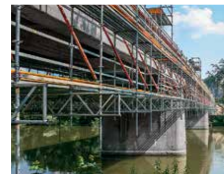
Obslužná pojazdná lávka šírky 8,00 m slúžila pre montáž zaveseného lešenia a obslužná lávka šírky 15,75 m pre demontáž zaveseného lešenia.
