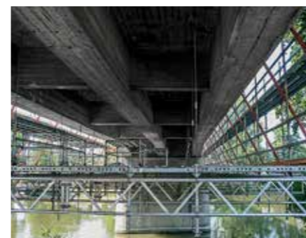
Pre bezpečnú rekonštrukciu mosta bolo nasadených 1 000 m 2 zaveseného modulového lešenia PERI UP Rosett a 520 m 3 modulového priestorového lešenia PERI UP Rosett.
