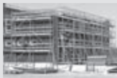
Pracovné lešenie na stavbách
