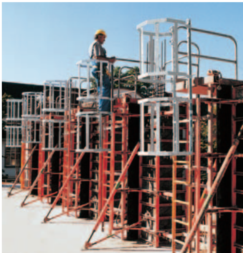
Výstupný rebrík pre bezpečný výstup na betonársku plošinu.
