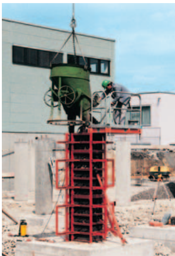
Bezpečná betonáž v každej výške s betonárskou plošinou PERI.
