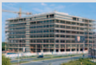
Pracovné lešenie fasádne
