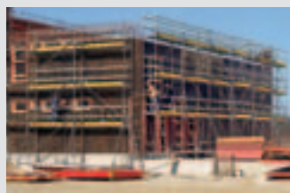
Pracovné lešenie na stavbách
