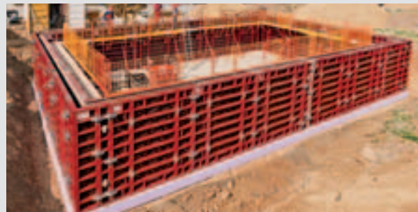
Krátka doba výstavby – vysoká bezpečnosť. MAXIMO a PROKIT na lávkach pre betonáž. Rodinný dom, Weißenhorn, Nemecko
