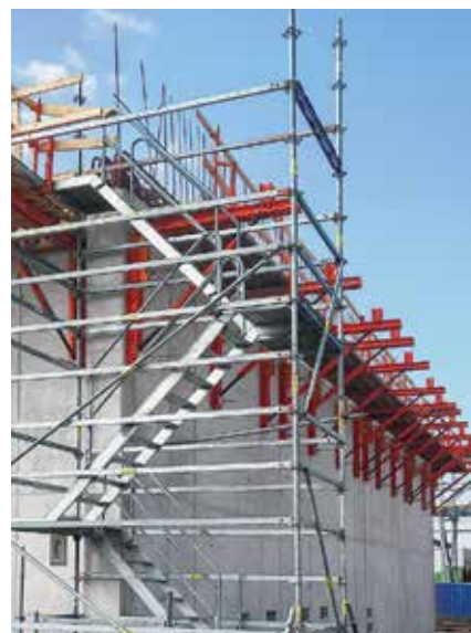
Debnenie atiky zo systému VARIOKIT a schodisková veža PERI UP Rosett.
