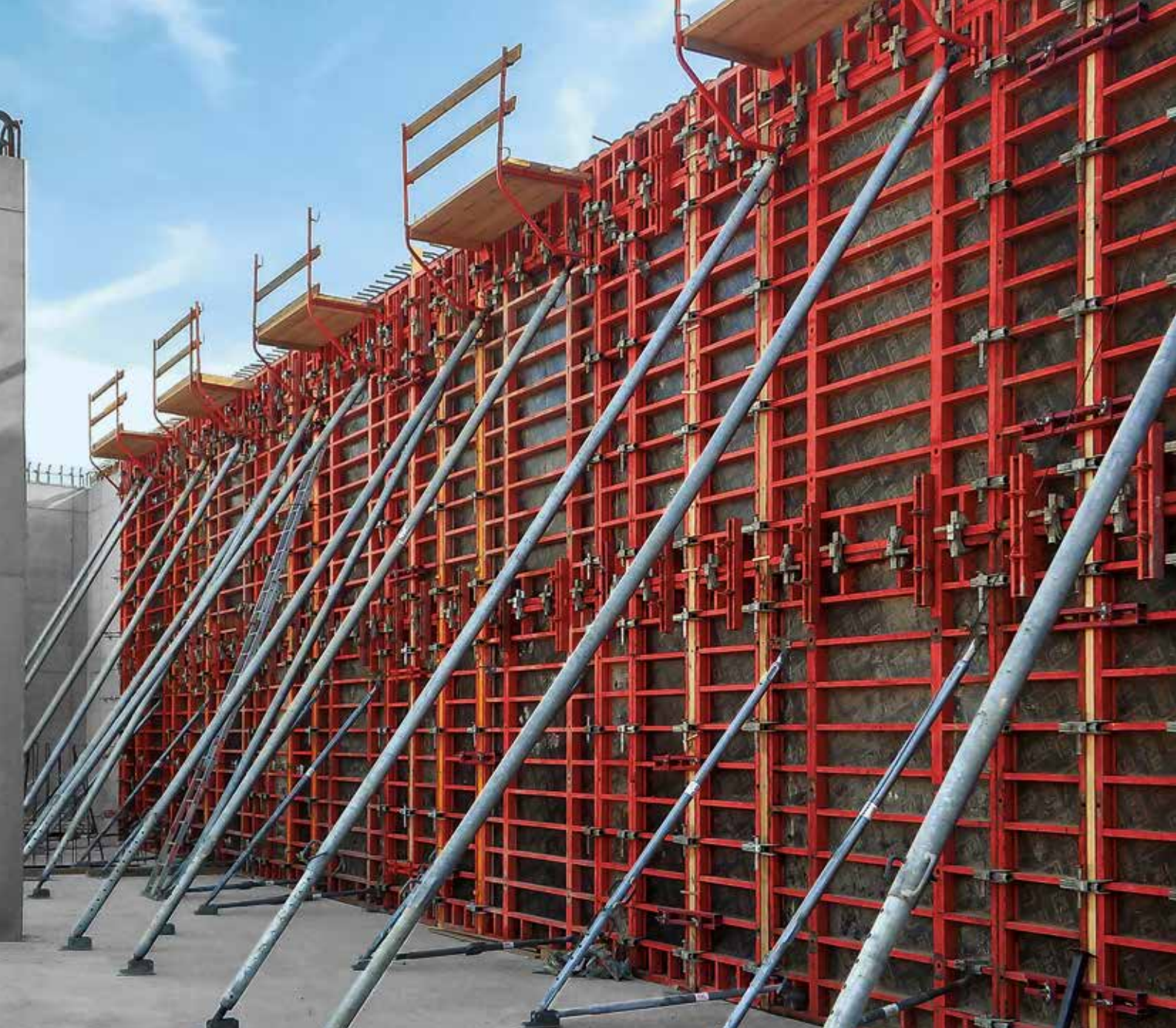
Stabilizovanie debnenia použitím stabilizátorov RS 210, RS 450 a RS 1000.
