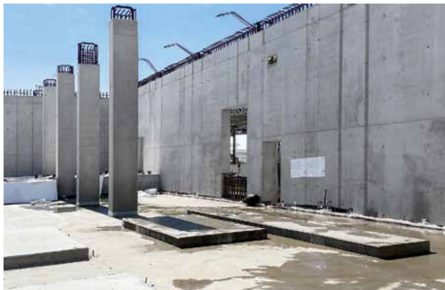
Dokonale rovné a pohľadové obvodové steny a stĺpy realizované systémom PERI TRIO 330.
