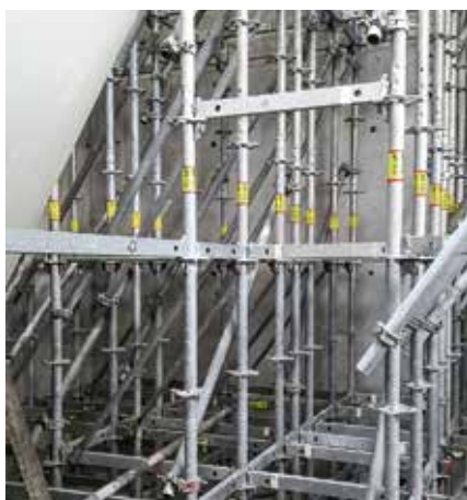
Podopretie debnenia šikmej stropnej dosky bolo realizované pomocou podperného lešenia PERI UP. Pri debnení vysokých stropov boli použité podperné veže ST 100.
