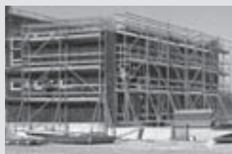
Pracovné lešenie na stavbách
