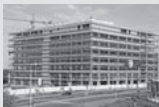
Pracovné lešenie fasádne
