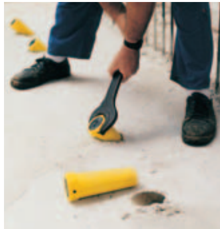
...a ľahké odstránenie montážneho kónusu po betonáži.
