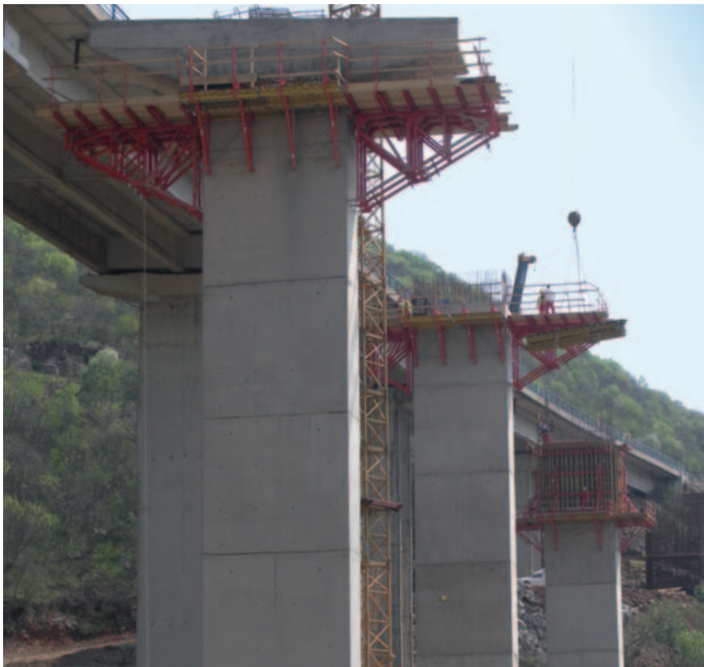
Nasadenie oporných rámov SB-A, B ako pracovných vysokoúnosných horizontálnych konzol.
