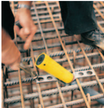
Jednoduché upevnenie kotvenia k výstuži...
