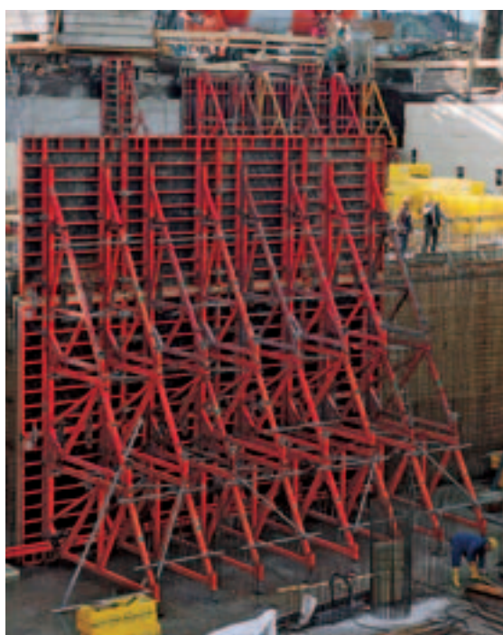
8,75 m vysoká betónáž s opornými rámiami SB-A0, A, B, C a stenovým debnením TRIO.
