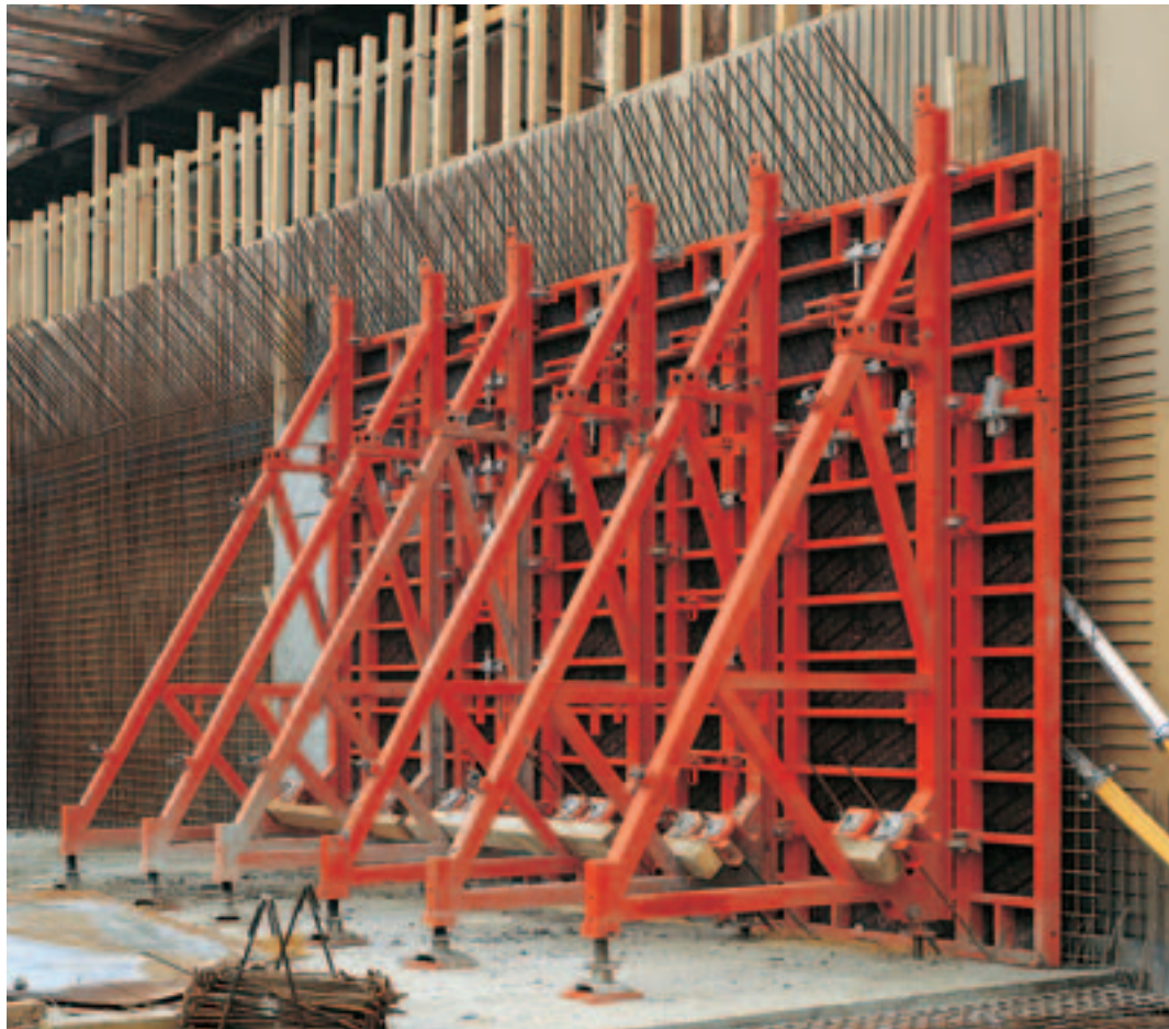
Betonáž na výšku 3,90 m s opornými rámiami SB-B, C so systémom TRIO.
